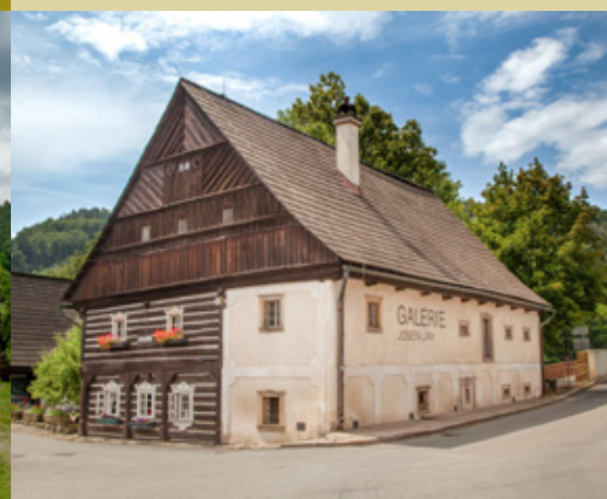
Boučkův statek na Malé Skále Bouček-Hof in Malá Skála
