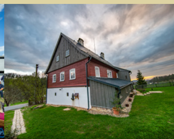
Stará škola v Křižanech Alte Schule in Křižany
